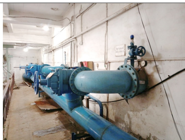
Рисунок 6.4.2 – Коллектор водозабора
