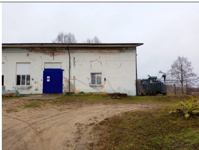
Рисунок 6.4.3 – Здание старой НС-1
