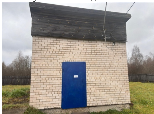
Рисунок 64.15 – Павильон скважины п. Новый
