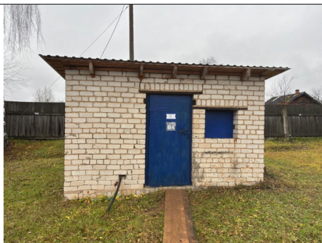
Рисунок 6.4.17 – Павильон скважины ул. Громова
