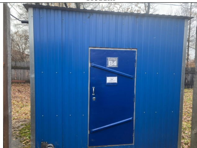
Рисунок 6.4.18 – Павильон скважины ул. Пушкина
