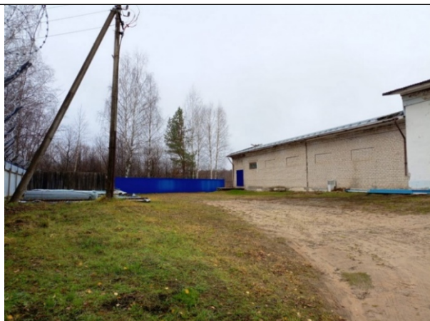
Рисунок 6.4.5 – Здание новой НС-1
